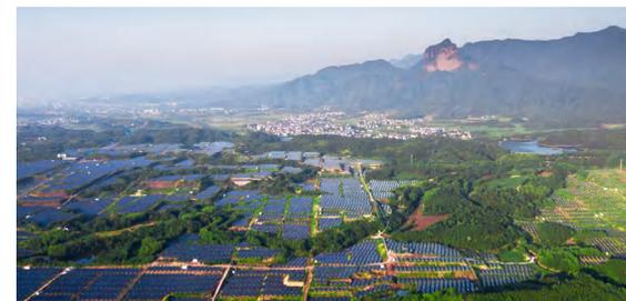
**案例 3：**“治沙面积 2.5 万亩 - UNCCD 光伏治沙案例”，原始地貌大多属于特大沙段，最大高差达 46 米，项目分三期建设共 310MW。
